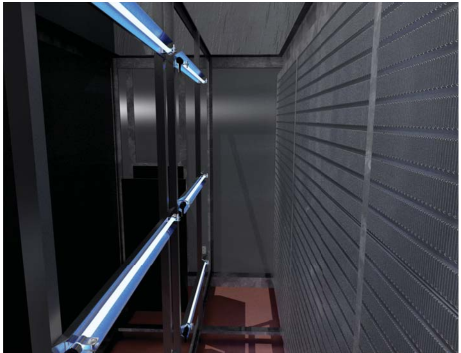
CCX64 3X2 UV-system Monterat mot kylbaffel
